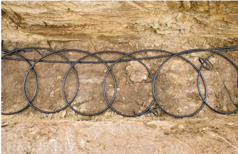
Рис 7.12. Тепловая энергия с низким потенциалом добывается из грунта ниже глубины промерзания (иллюстрация с сайта http://www.rmnt.ru/ )
