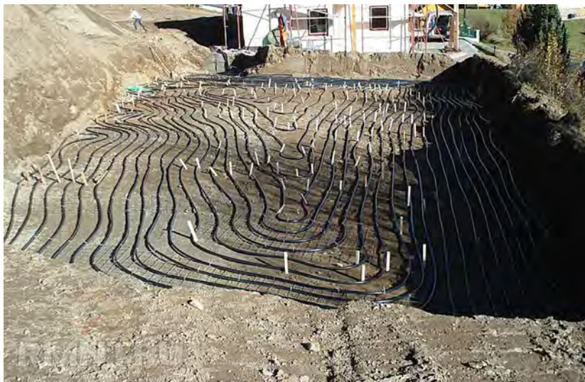
Рис. 7.15. Кольцевой змеевик теплообменника (иллюстрация с сайта http://www.rmnt.ru/ )
